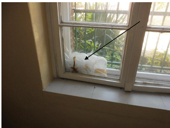
Uszkodzone szklenie okna
