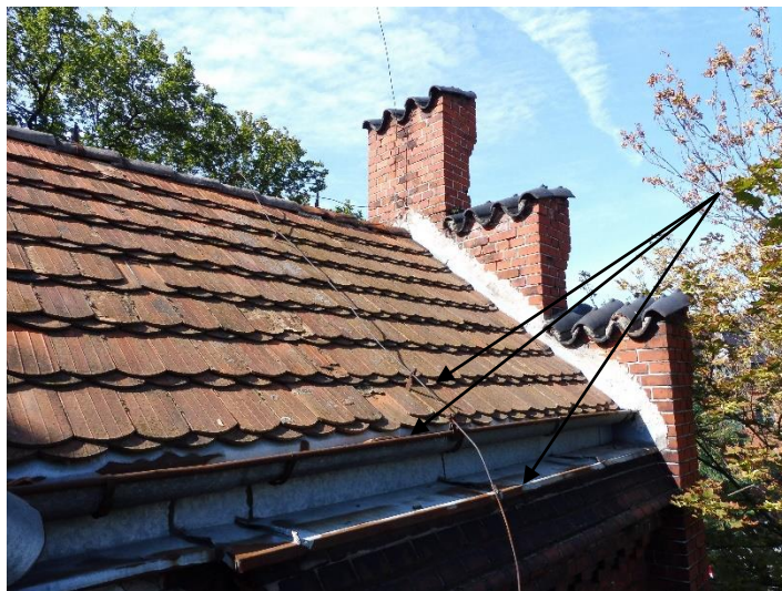
Korozja obróbek, instalacji odgromowej oraz zabrudzenia rynien
