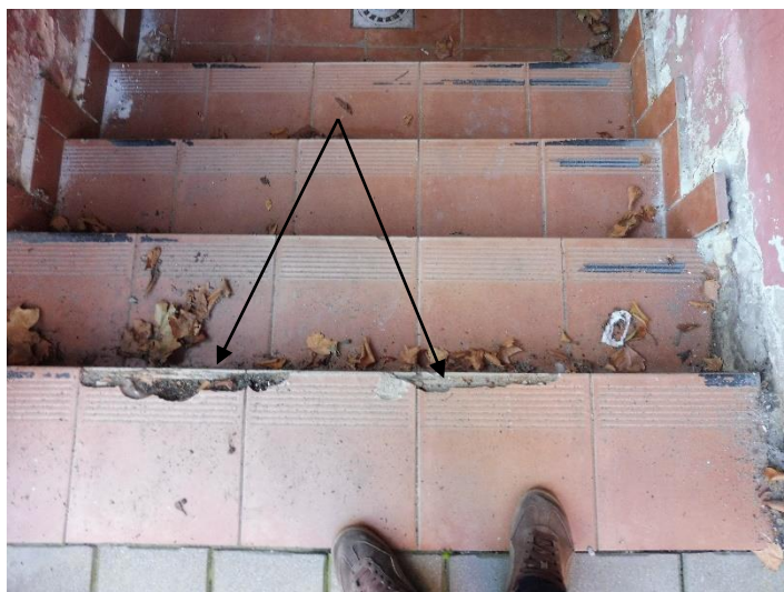
Uszkodzenia płytek przed wejściem do obiektu
