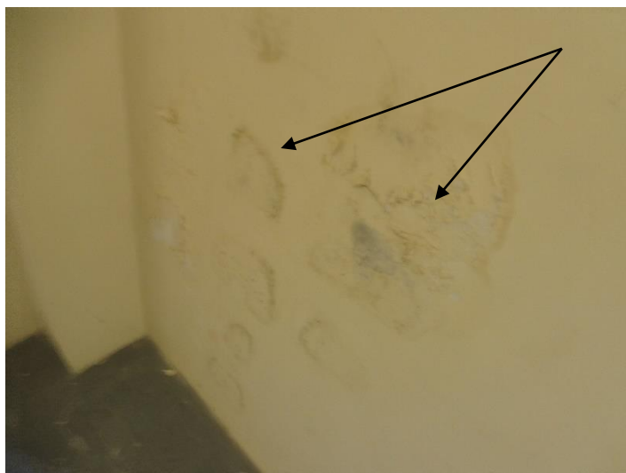
Zagrzybienie i zawilgocenie na jednej ze ścian suterenu
