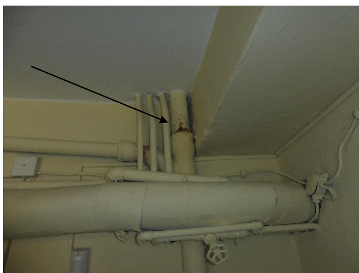
Korozja instalacji C.O.
