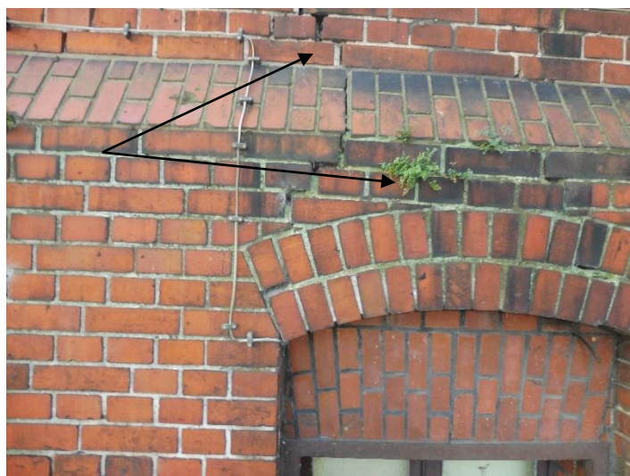
Porost roślinności na ścianach budynku
