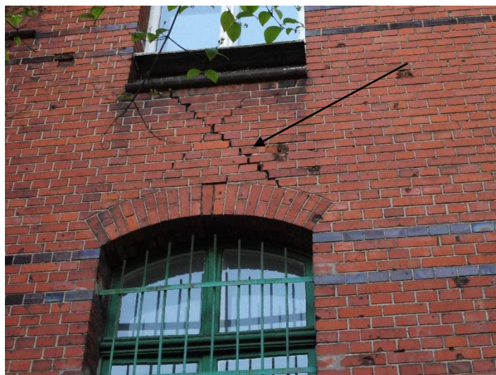
Widoczne spękania skośne na ścianach nośnych
