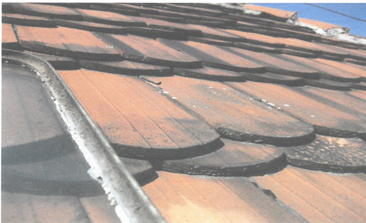
Fot. 16 Jak fot. 15- drobne ubytki i pęknięcia
