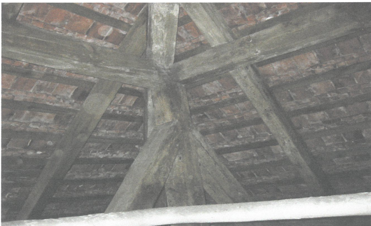
Fot. 20 Widok ogólny na dobry stan więźby dachowej
