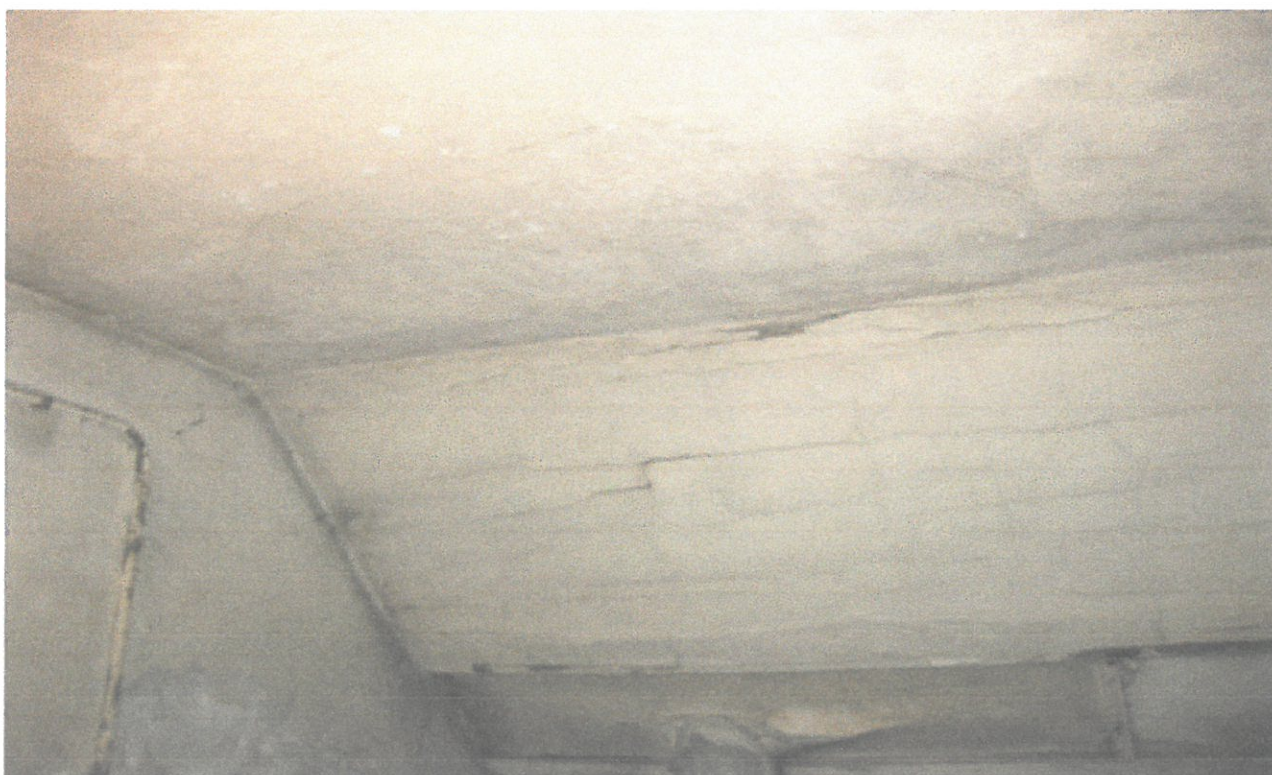
Fot. 18 Strych, krokwie obudowane supremą, spękany tynk na trzcinie
