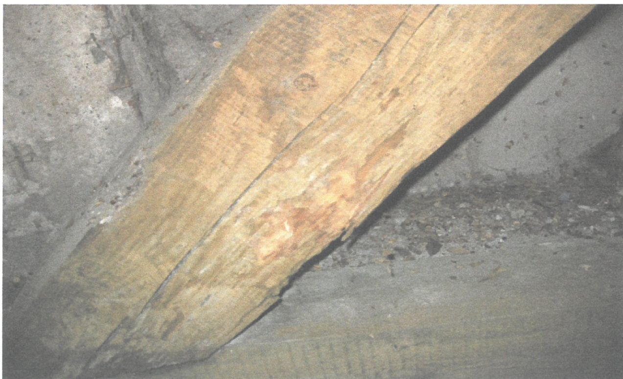
Fot. 24 Ubytek korozyjny miecza
