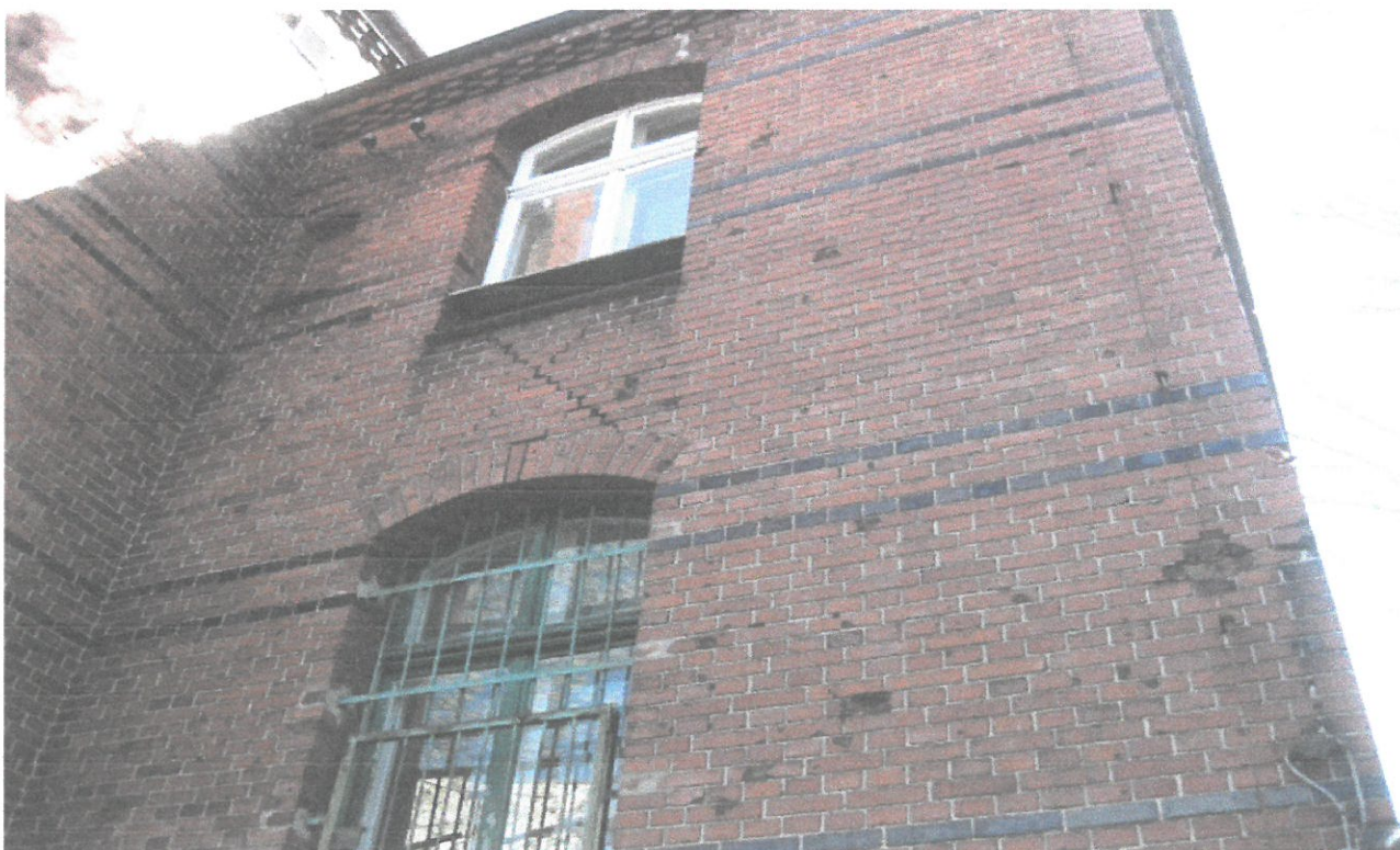
Fot. 10 Elewacja pł.-zach, ukośne zarysowania pomiędzy oknami, rozluźnienie zwornika nad oknem parteru
