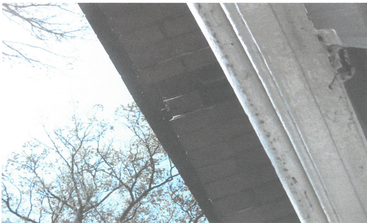
Fot. 8 Jak fot.4- zbliżenia na ubytek zwornika na piętrze
