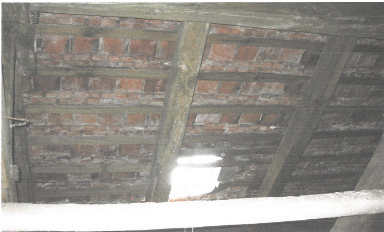
Fot. 21 Wymienione krokiewie i łąty więźby dachowej
