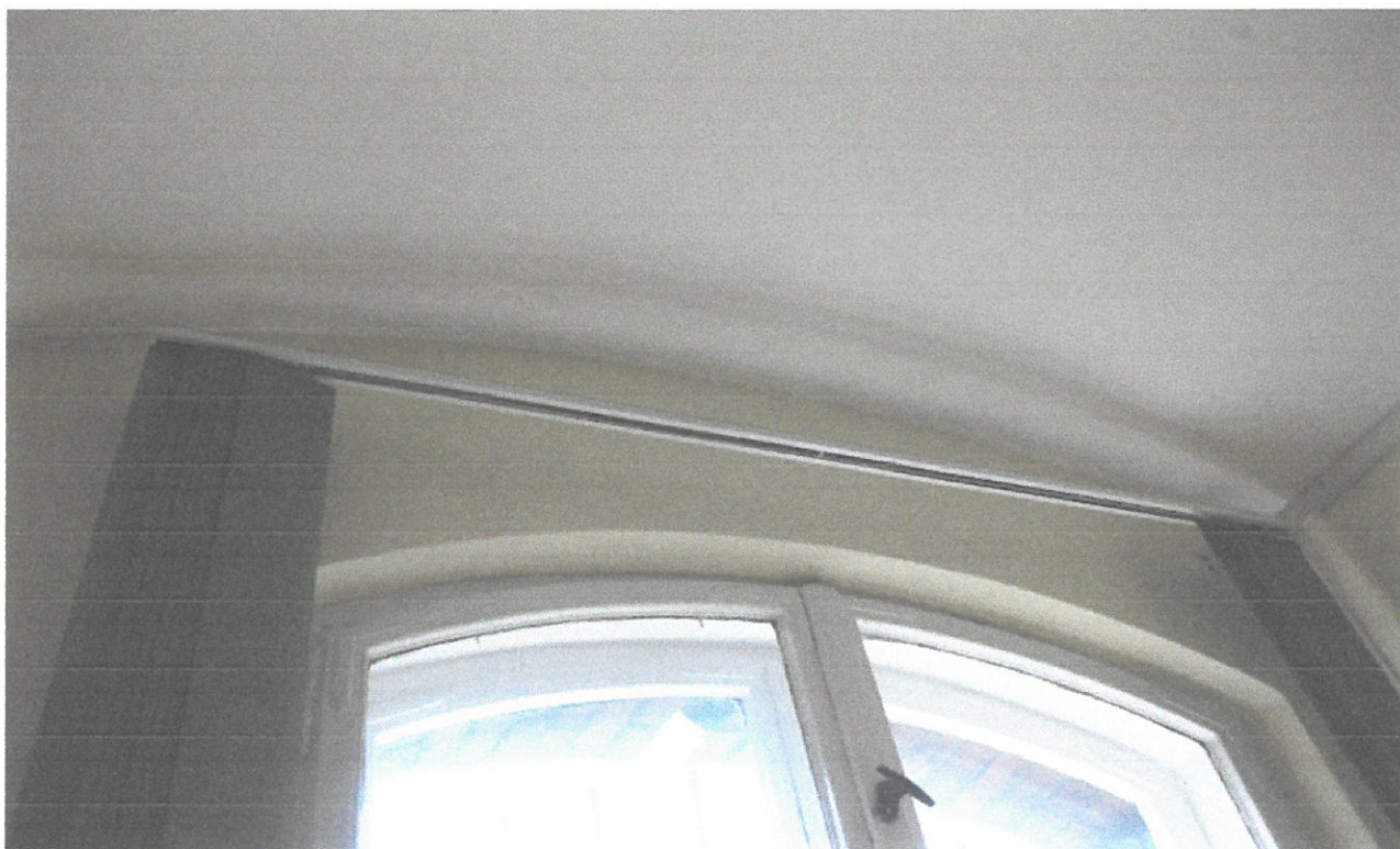
Fot. 5 Jak fot. 4 – widok od wewnątrz; brak śladów zarysowań na parterze
