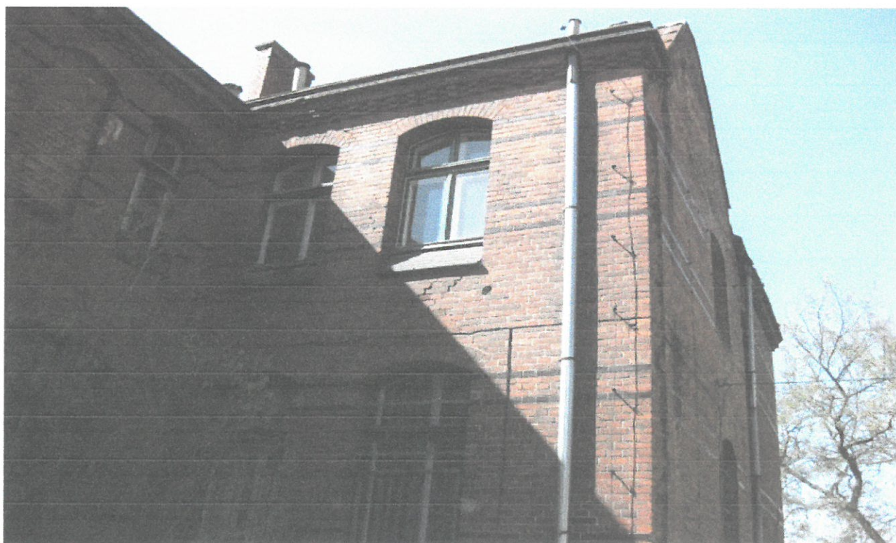
Fot. 14 Elewacja pł-zach widoczne ukośne zarysowania
