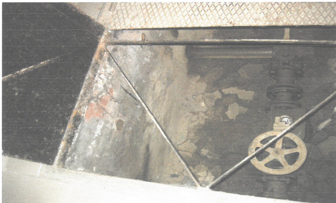
Fot. 34 Niewielkie ślady zawilgoceń w studzience zaworu wodnego
