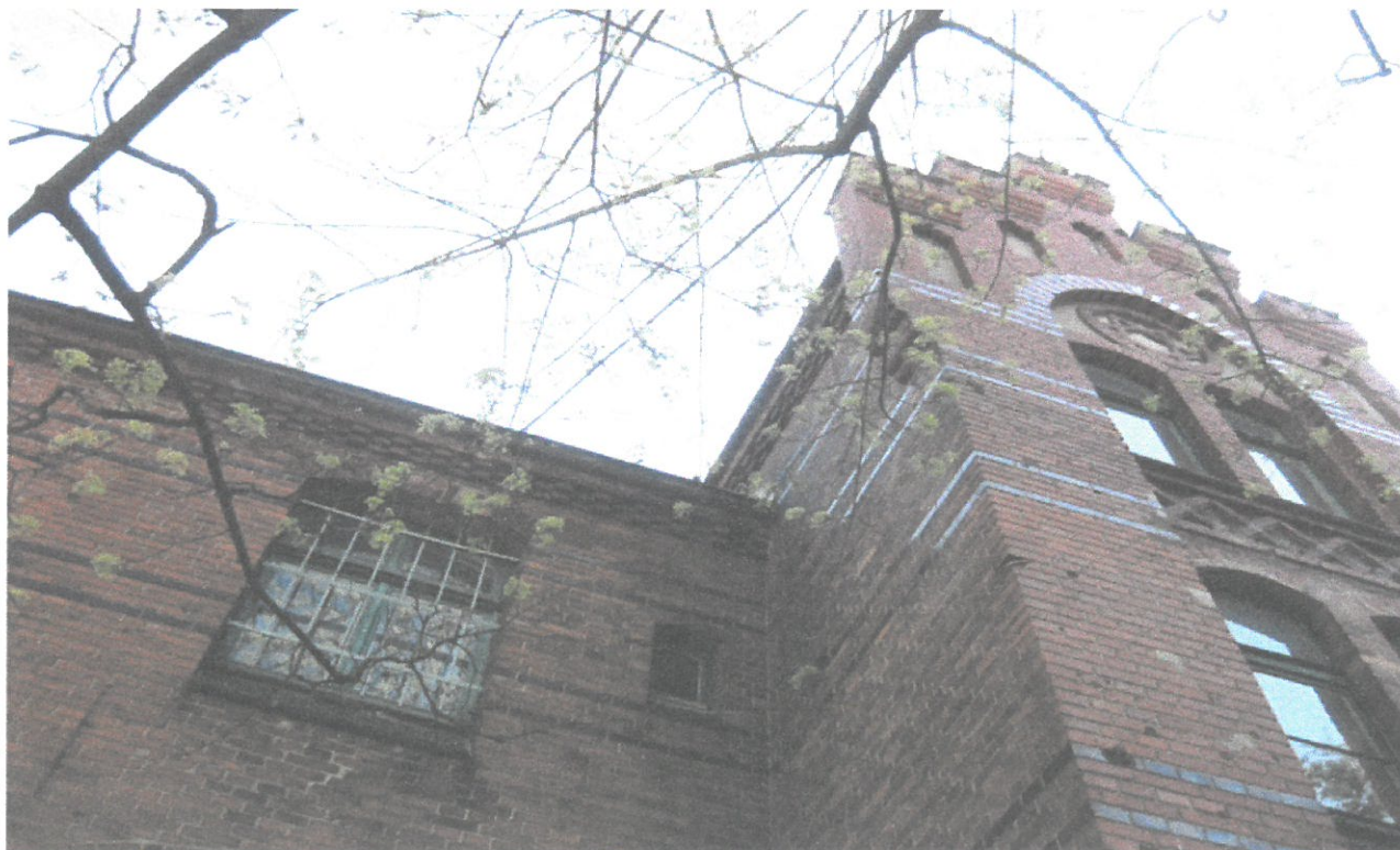
Fot. 12 Elewacja pł.-zach, drobne ubytki cegieł i zarysowania
