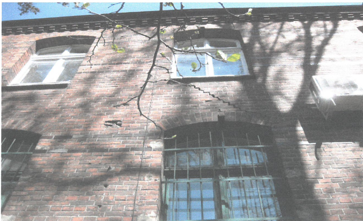
Fot. 4 Jak fot 3- zbliżenie na ukośne zarysowania muru, widoczne ubytki zworników w łukach okien
