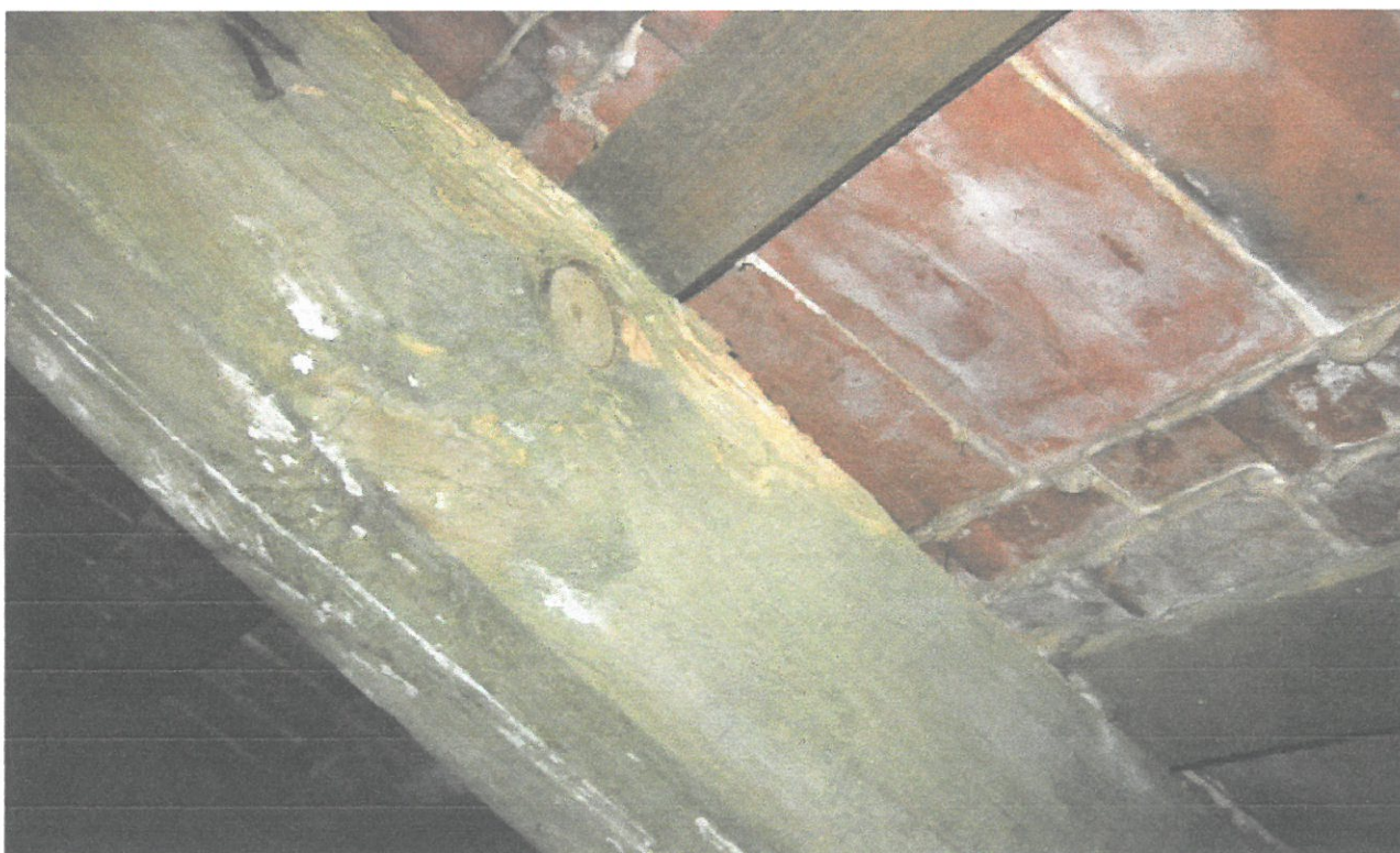
Fot. 30 Niewielki ubytek korozyjny krokwi
