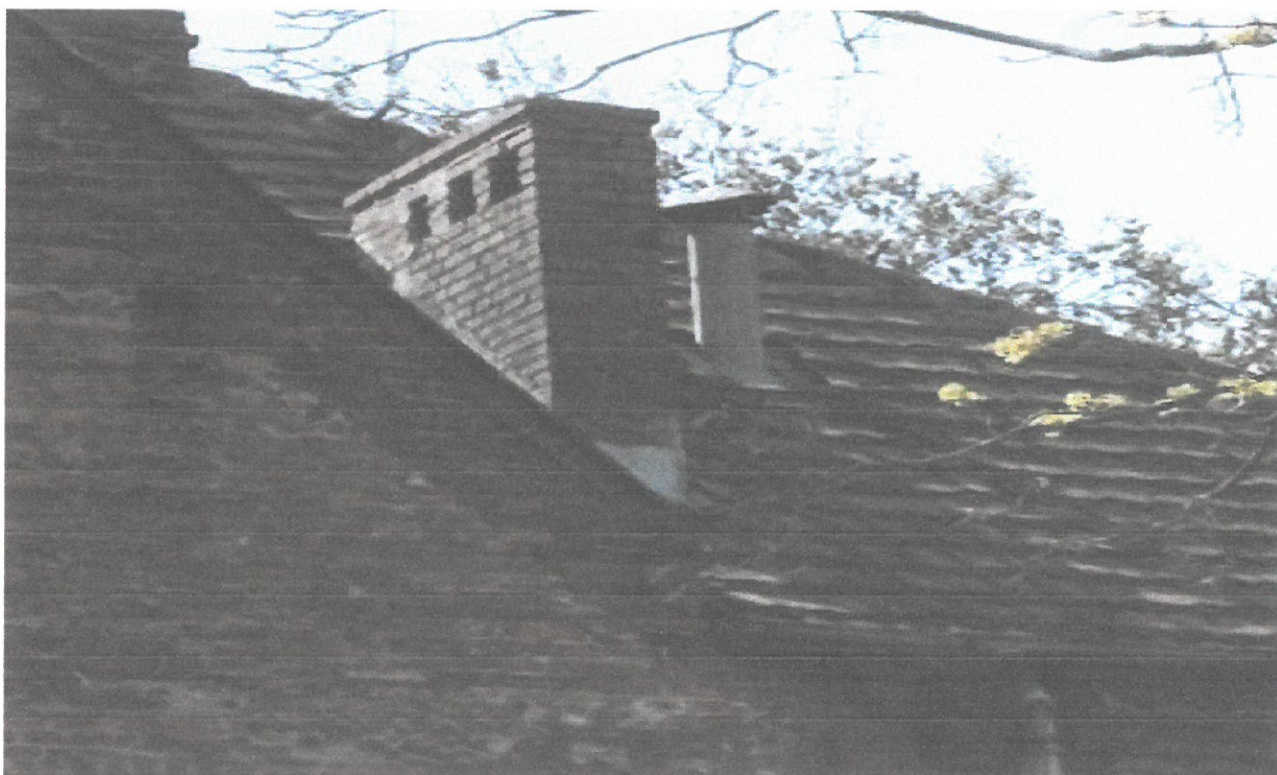
Fot. 13 Elewacja pn-zach, widoczne rozluźnienie cegieł w kominie
