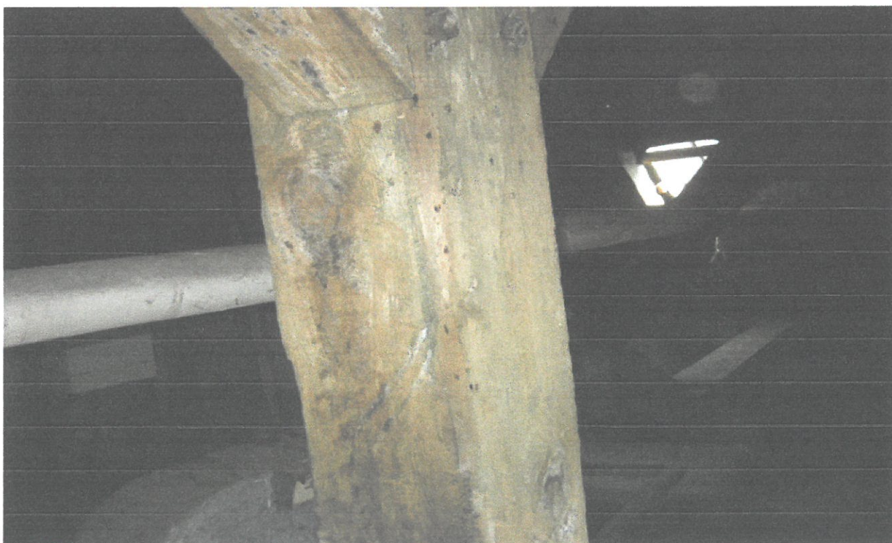
Fot. 22 Stare ślady żerowania spuszcza domowego
