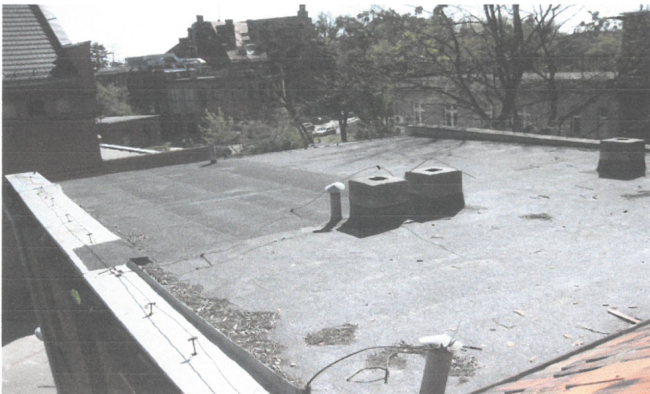
Fot. 17 Pokrycie papowe, widoczne kominy wentylacyjne bez wylotów bocznych, urwane wsporniki instalacji odgromowej
