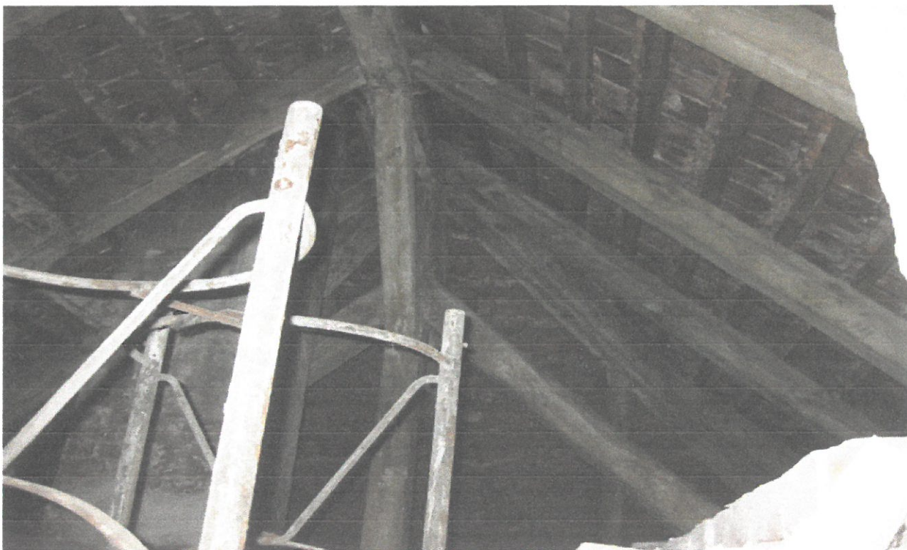
Fot. 25 Widok ogólny na dobry stan więźby dachowej wyższej części dachu
