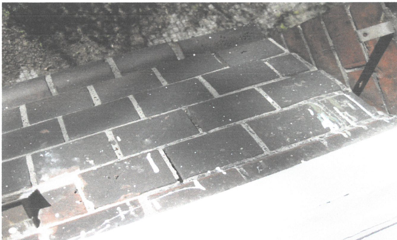
Fot. 9 Jak fot. 4 – zbliżenia pęknięć okapnika; rozwartość rys \sim 2\text{mm} , przemieszczenia pionowe \sim 4\text{mm}
