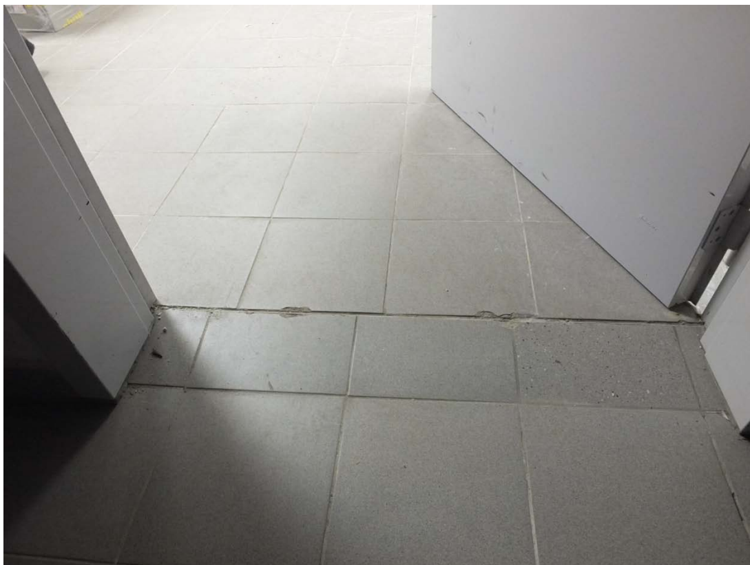
Wymiana pękniętych płytek gresowych pom. laboratoryjne B-1.P.06
