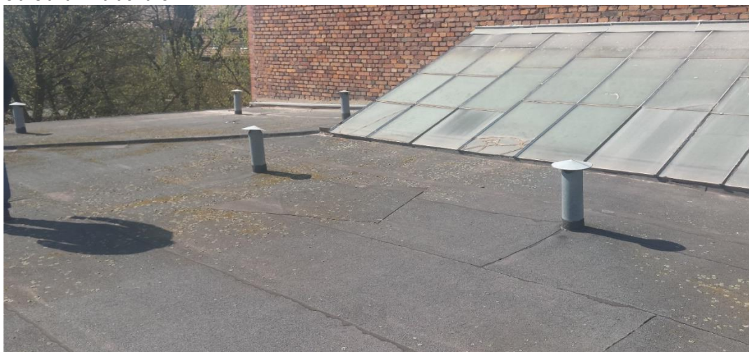
Zdjęcie dachu i świetlika do wymiany
