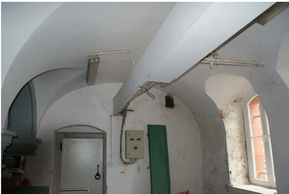
Zdj nr 4 Zawilgocenia ścian zewnętrznych
