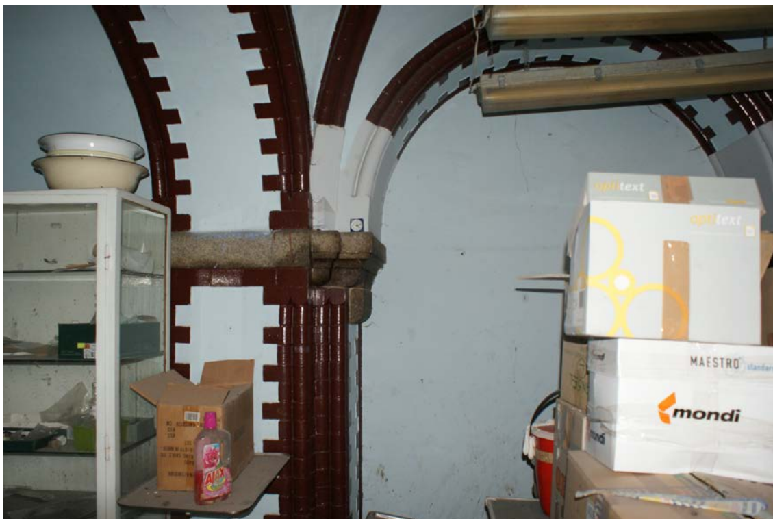
Zdj nr 6a Pilaster ceglany ( wymalowania cegły profilowanej farba olejna na kolor brązowy ), zabrudzenia konsol granitowych, wymalowania gurtów sklepiennych z cegły profilowej na kolor brązowy farbami olejnymi.
