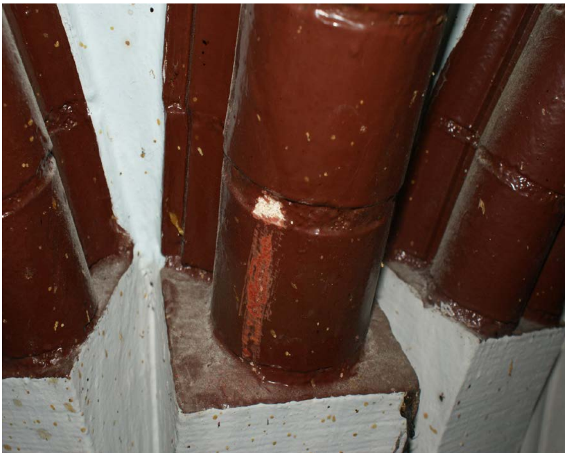
Zdj nr 12 Odkrywka pod wymalowaniami olejnymi na cegle profilowanej ( gurty sklepienia krzyżowego, cegła profilowa i fuga )
