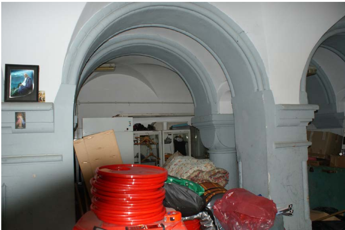
Zdj nr 1. Wymalowania słupów ceglanych i kolumn kamiennych farbami olejnymi
