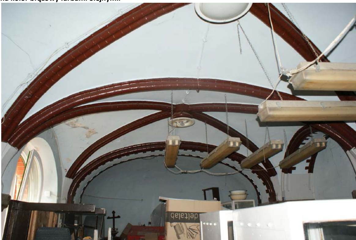
Zdj nr 7 Wymalowania gurtów sklepiennych z cegły profilowej na kolor brązowy farbami olejnymi.
