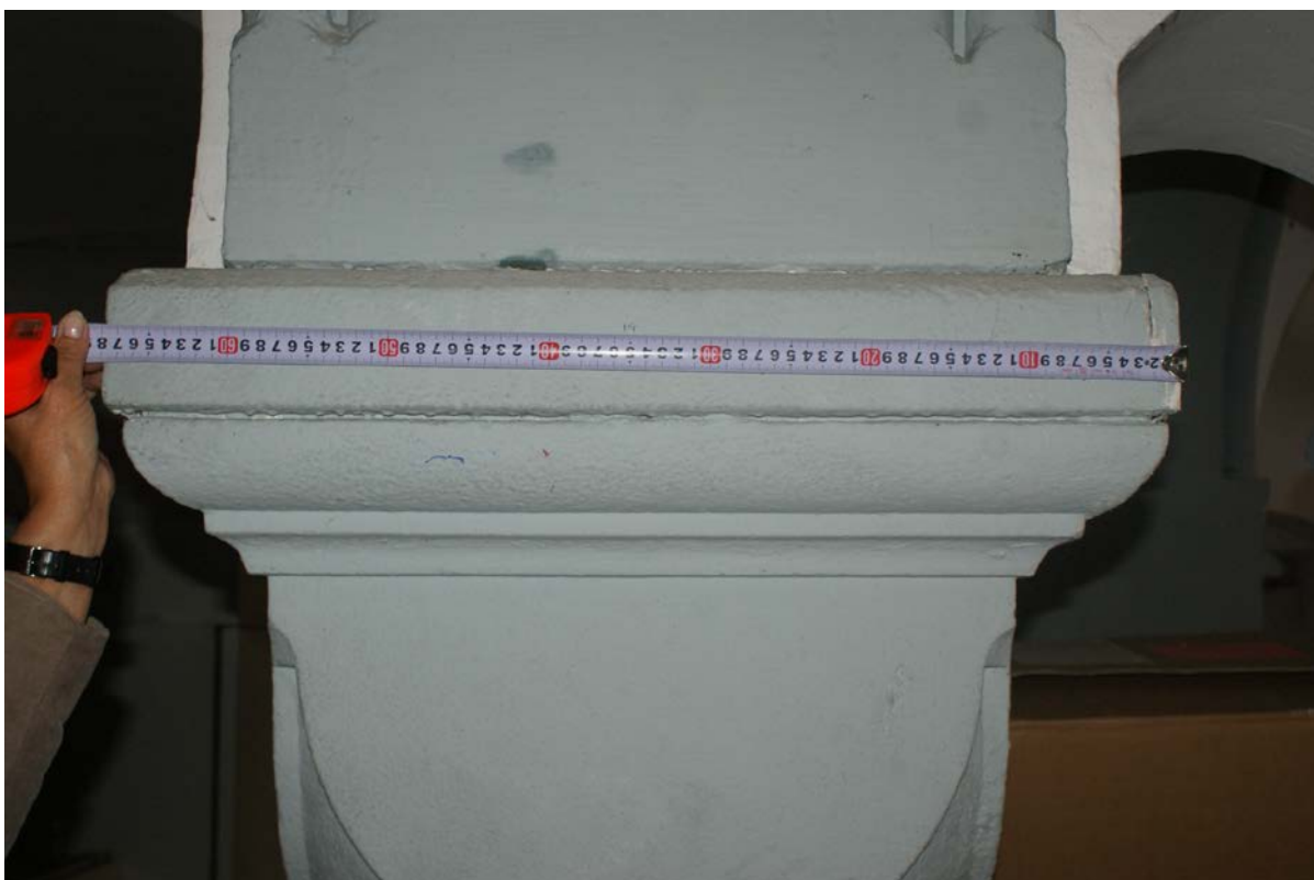
Zdj nr 9 Głowica kolumny granitowej ( zabrudzenia ) i wymalowania farbami olejnymi.
