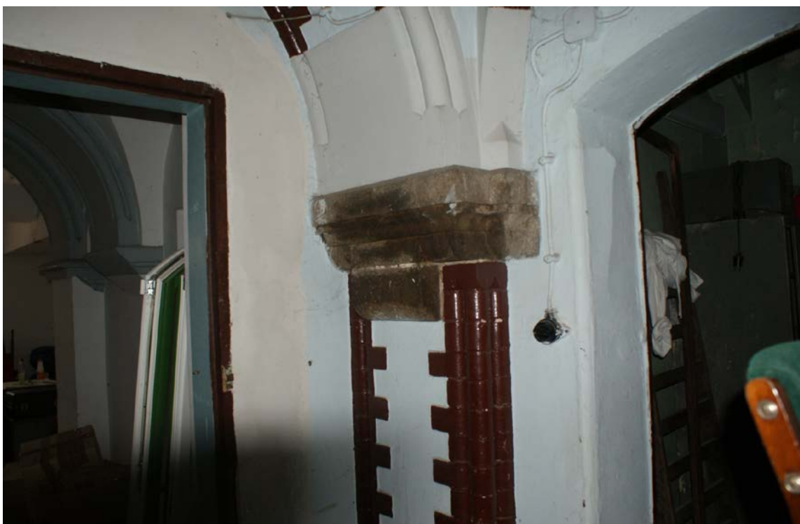
Zdj nr 5 Pilaster ceglany ( wymalowania cegły profilowanej farba olejna na kolor brązowy ), zabrudzenia konsol granitowych, wymalowania gurtów sklepiennych z cegły profilowej na kolor brązowy i biały farbami olejnym
