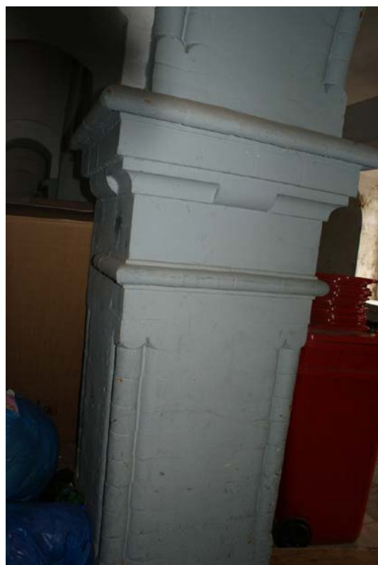
Zdj nr 2 i 3 Kolumna granitowa zbrudzenia ) Kolumna ceglana ( wymalowania olejne wątków ceglanych )
