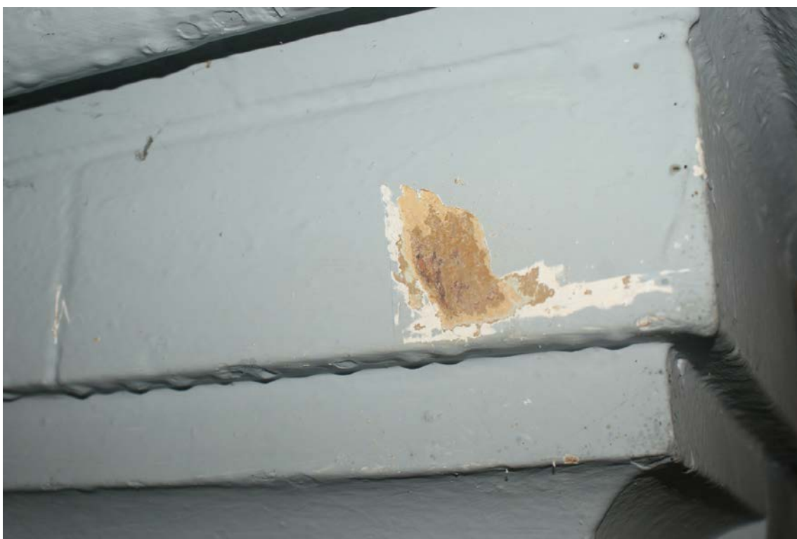
Zdj nr 11 Odkrywka pod wymalowaniami olejnymi na cegle profilowanej ( głowica kolumny ceglanej
