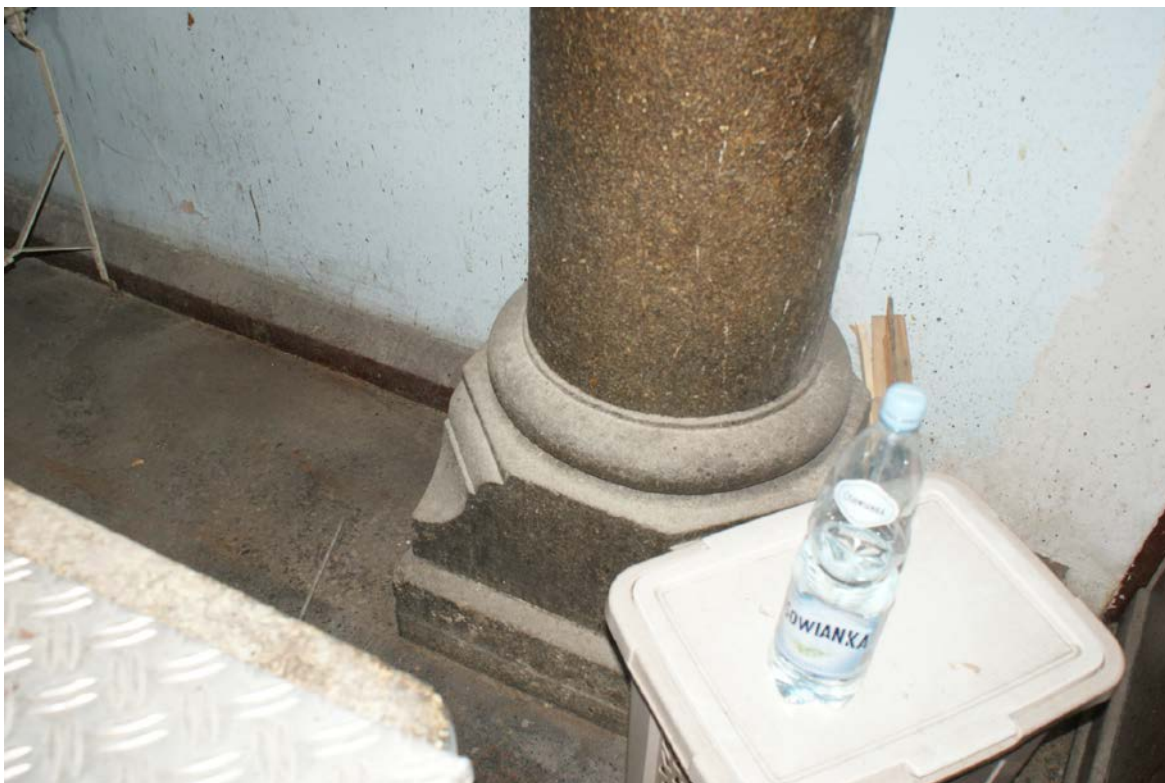
Zdj nr 8 Baza kolumny granitowej ( zabrudzenia )
