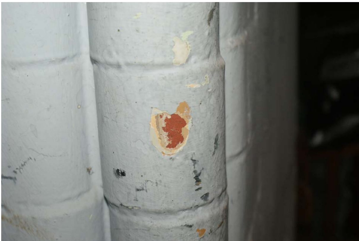
Zdj nr 10 Odkrywka pod wymalowaniami olejnymi na cegle profilowanej.
