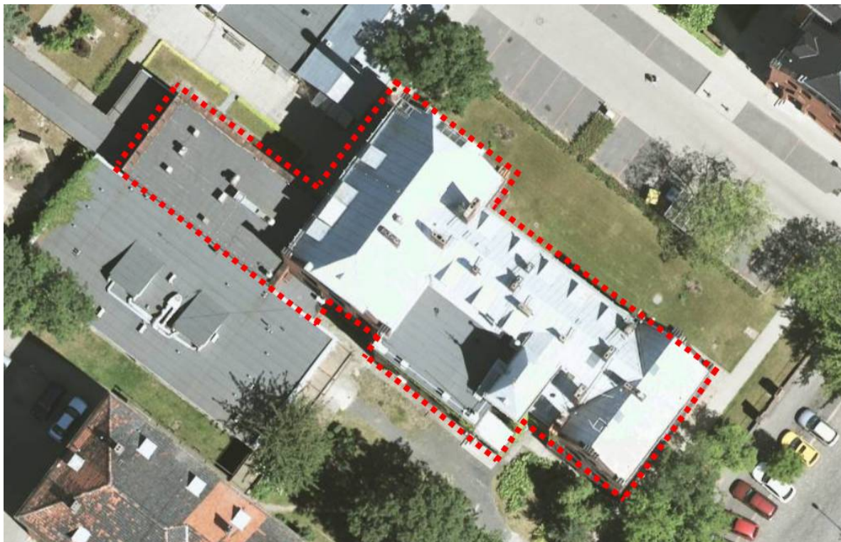
rys. 2 Widok dachu z góry z zaznaczonym zakresem opracowania
