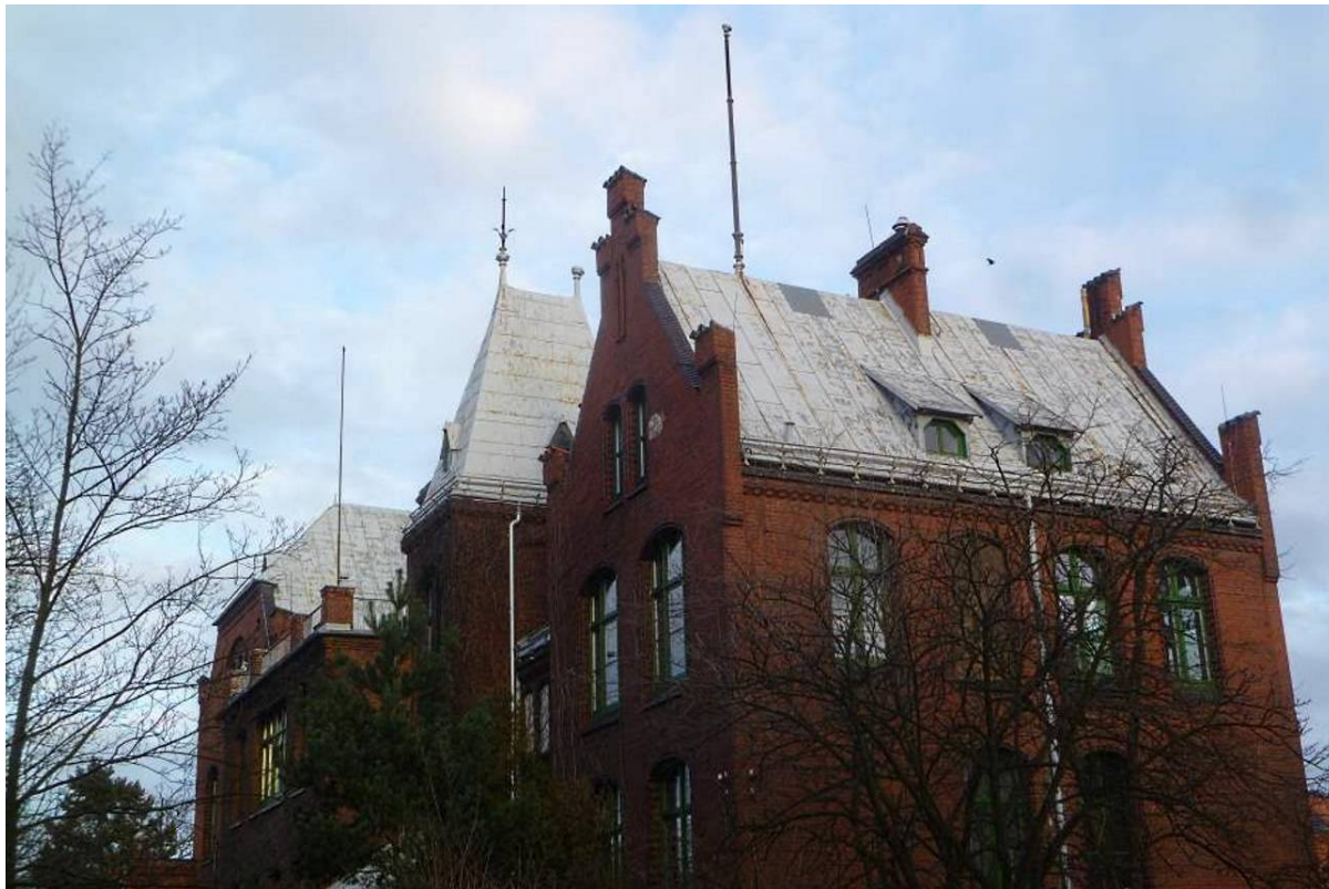
Rys. 6 Widok od południowego - wschodu
