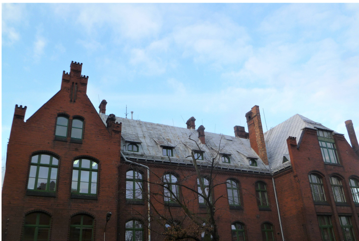
Rys.3 Widok od północnego - wschodu
