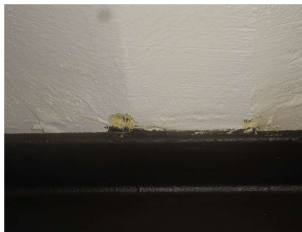
Odkrytki w celu identyfikacji belek stropowych nad piwnicą
