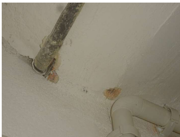
Odkrytki w celu identyfikacji belek stropowych nad piwnicą
