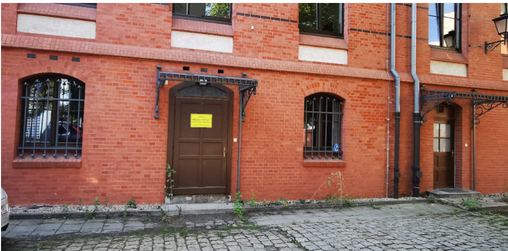
rys 2: elewacja frontowa, wejście do węzła.
